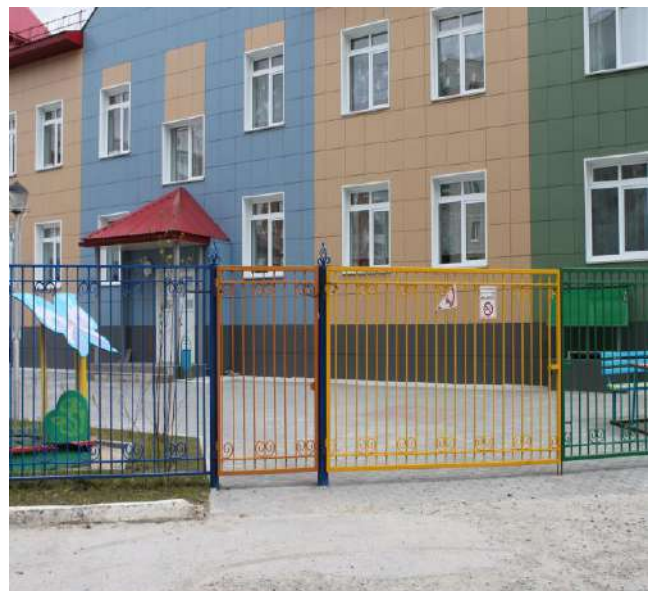
Фото 5. Вход №3 со стороны улицы Свободы
