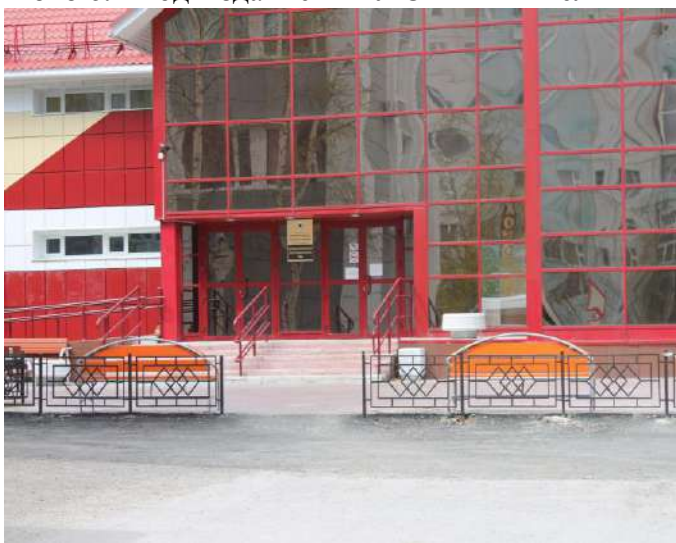
Фото 6. Вход в здание МАУ СШ «Вымпел»
